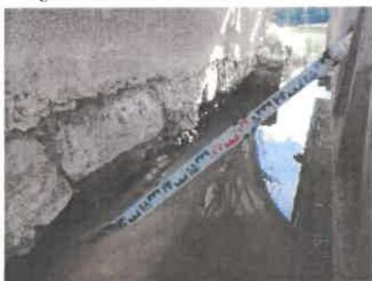
Figure 3: Affouillement en rive droite
