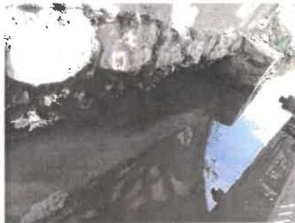
Figure 2: Lacune de la semelle en béton
