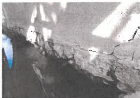
Figure 1: Lacune de la semelle en béton
